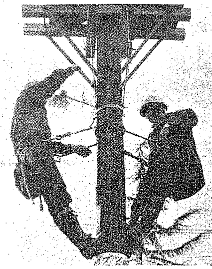
花春町での防犯灯取り付け
