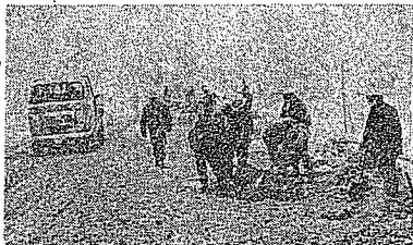
吹雪について今日も工事は続けられている
