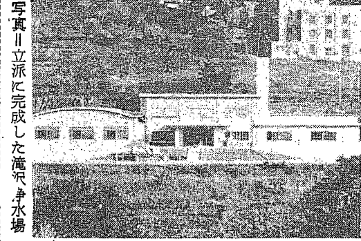
写真=立派に完成した滝沢浄水場
