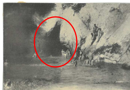
戸ノ口堰洞門（昭和7年） 洞門で水浴をする人々
