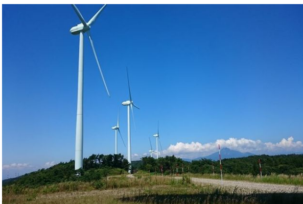
名称 会津若松ウィンドファーム 所在地 東山町(背あぶり山) 事業者 コスモエコパワー株式会社 設備容量 16,000kW (2,000kW×8基)
