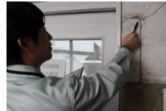
写真：職員による施設点検の様子 (イメージ)
