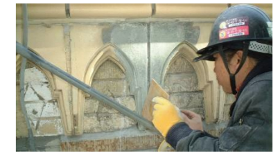
試験施工の例
