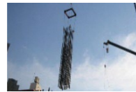
柱鉄筋先組工法
