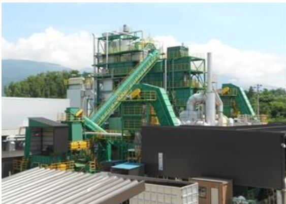
名称 グリーン発電会津 会津河東発電所 所在地 河東町工業団地 事業者 株式会社グリーン発電会津 設備容量 約5,700kW
