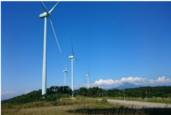
名称 会津若松ウィンドファーム 所在地 東山町(背あぶり山) 事業者 コスモエコパワー株式会社 設備容量 16,000kW (2,000kW×8基)
