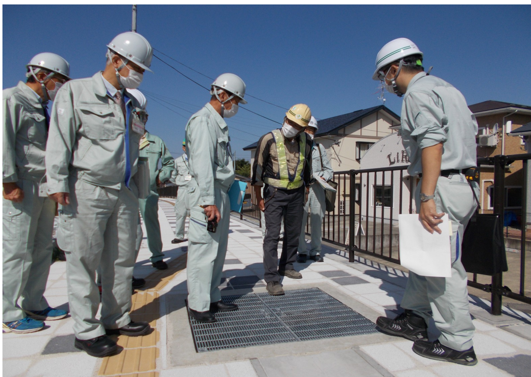
令和2年10月2日 現地実査（側溝流末柵の確認）
