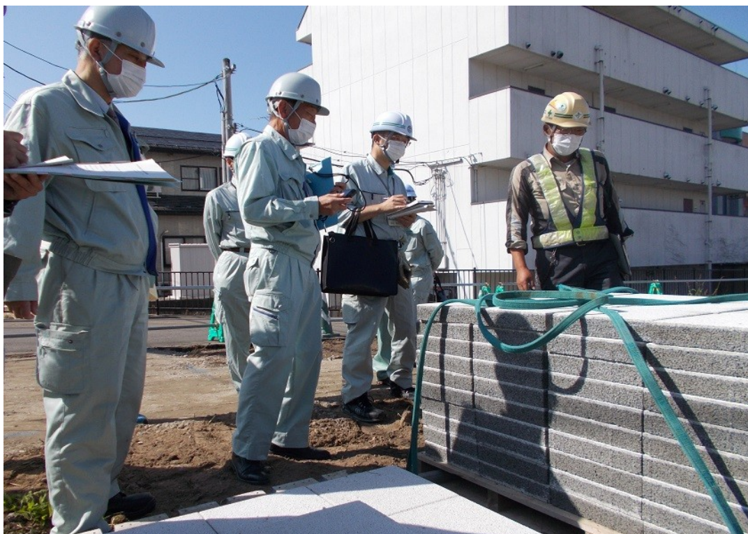
令和2年10月2日 現地実査（防滑透水性平板ブロックの現場保管確認）
