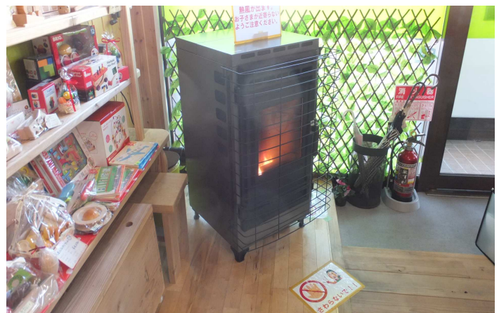
ペレットストーブの設置
