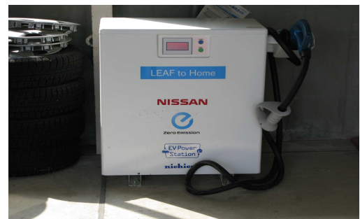
電気自動車から建物に給電もできるV2H
