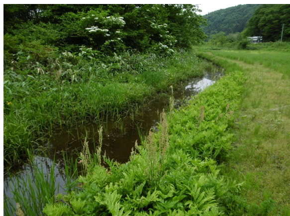
遮水板設置後の状況
