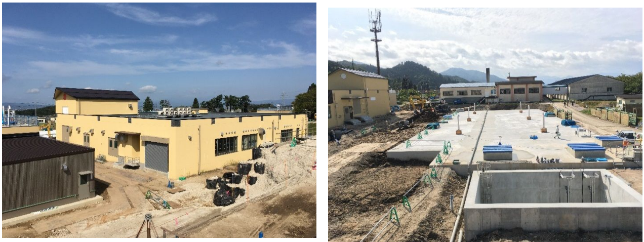
写真4 更新工事中の滝沢浄水場（平成28年度）
