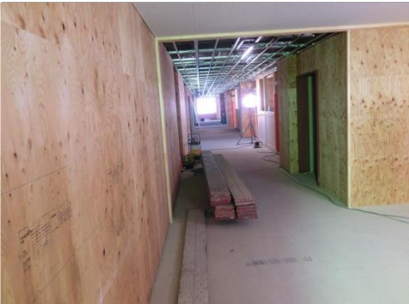
1F内装施工状況
