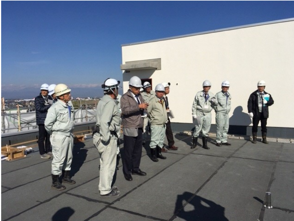
現地実査 平成30年11月16日
