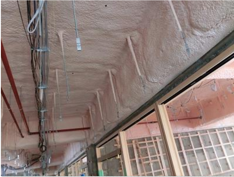
ウレタンフォーム施工状況
