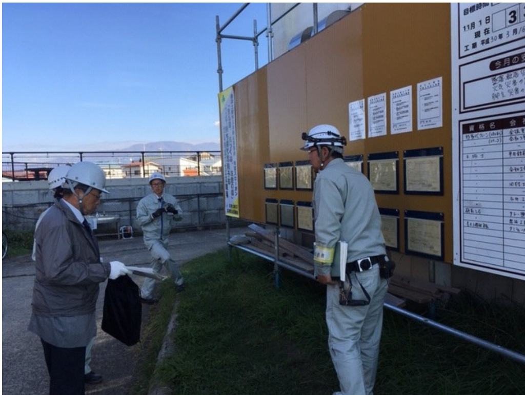
現地実査 平成30年11月16日
