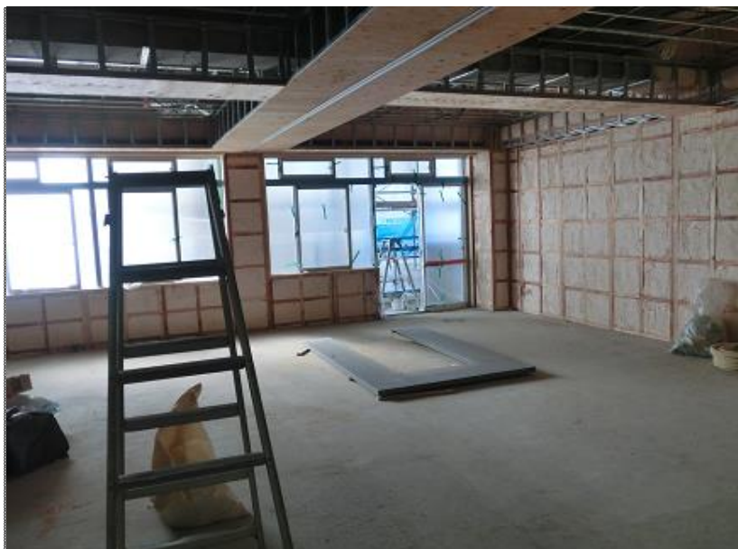
内装施工状況
