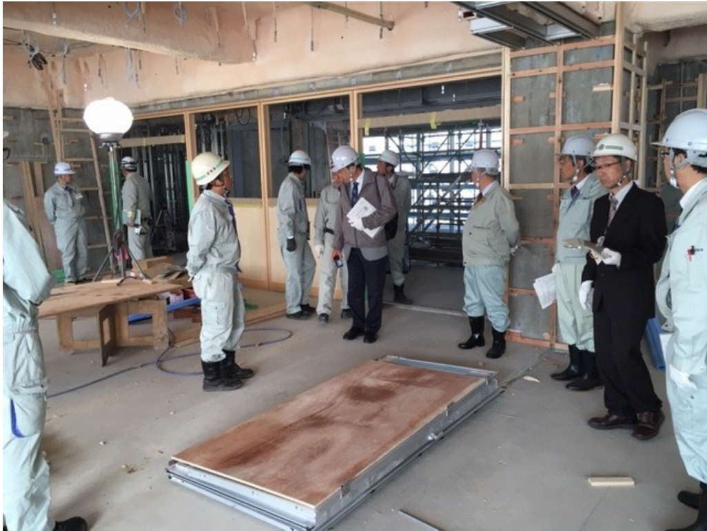
現地実査 平成30年11月16日
