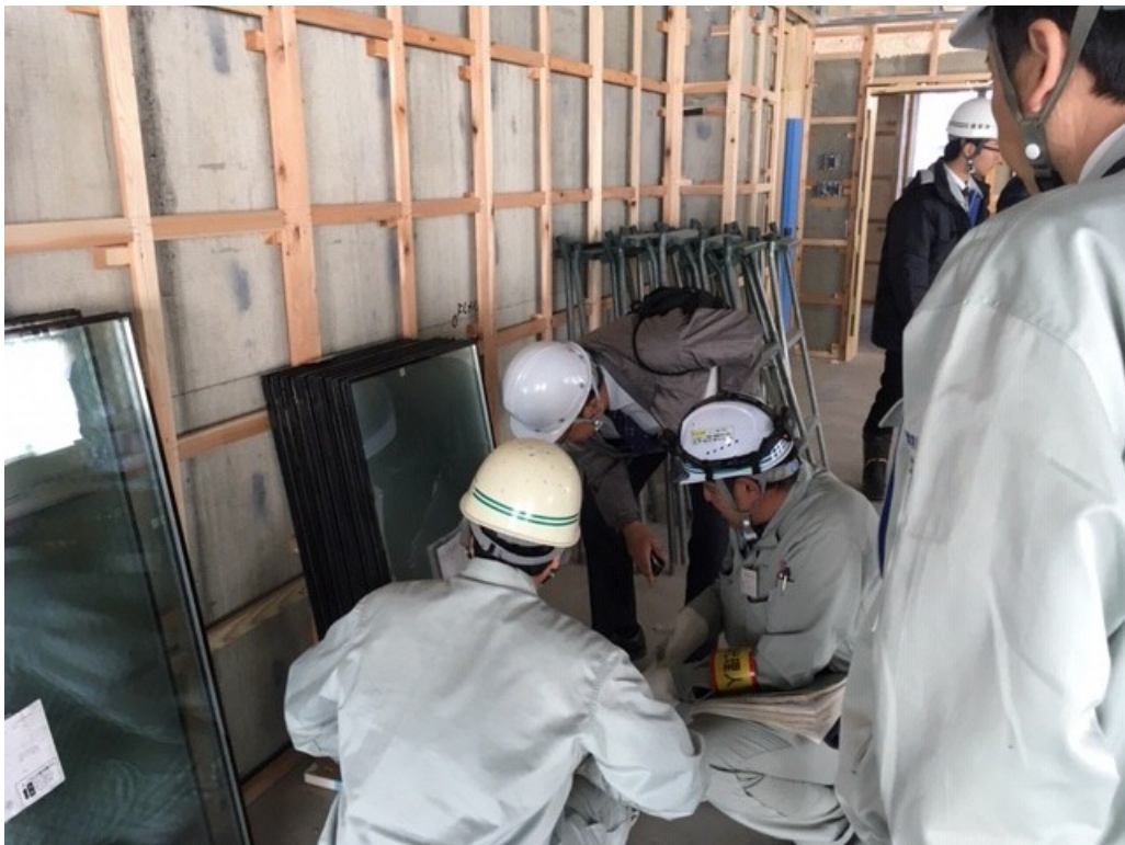
現地実査 平成30年11月16日
