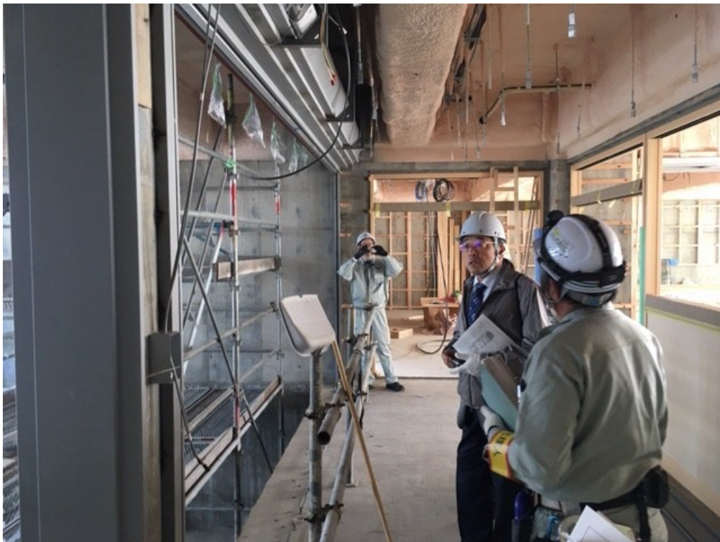
現地実査 平成30年11月16日
