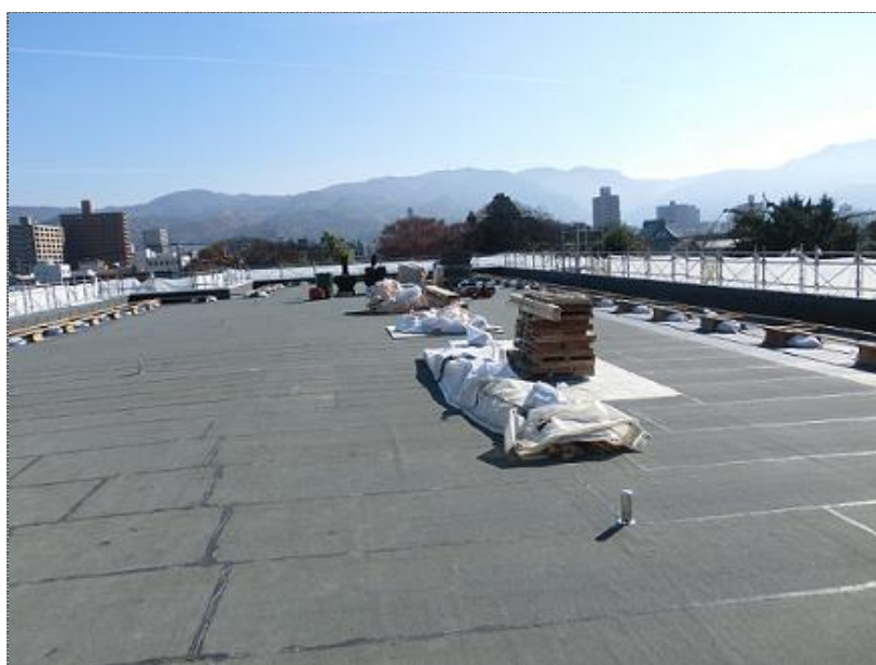
屋上アスファルト防水
