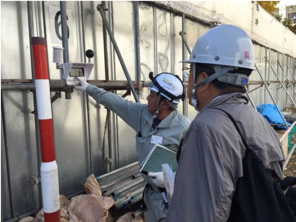
現地実査 平成30年11月16日
