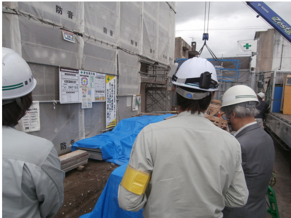
現地実査〔平成29年5月26日〕
