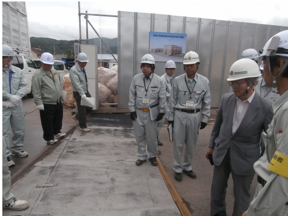
現地実査〔平成29年5月26日〕
