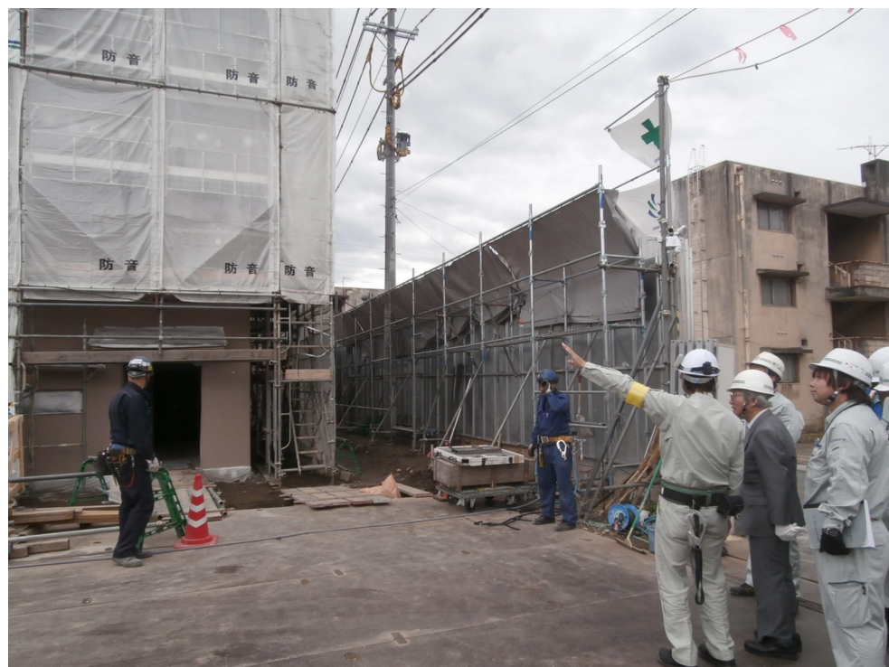
現地実査〔平成29年5月26日〕
