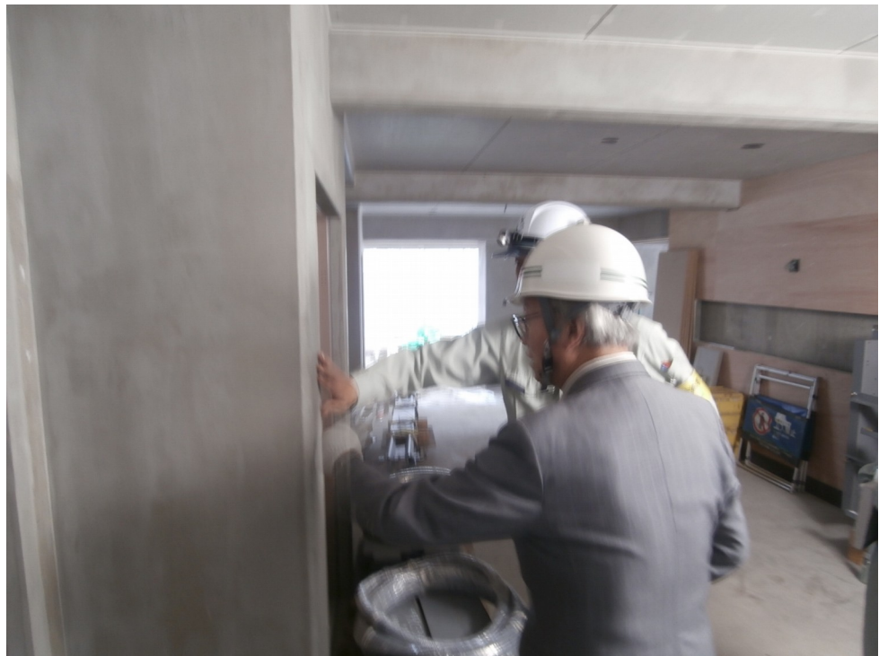
現地実査〔平成29年5月26日〕
