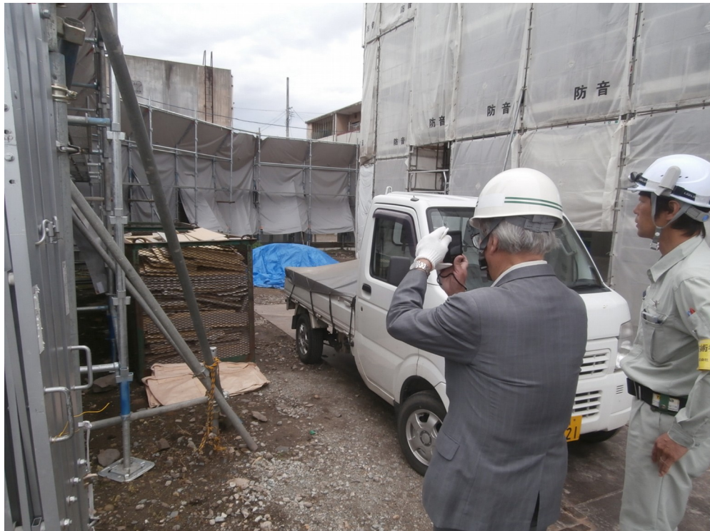
現地実査〔平成29年5月26日〕
