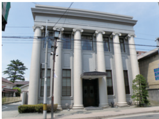
滝谷建設工業(株)会津若松店社屋 (旧郡山橋本銀行若松支店)
