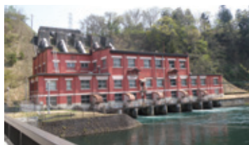
東京電力 猪苗代第2発電所
