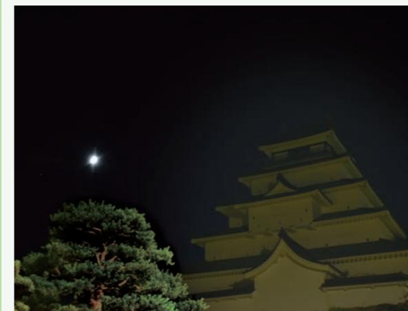
関係機関による一斉消灯の取り組みとして、7月7日に実施された「福島ライトダウンチャレンジ」では、鶴ヶ城天守閣のライトアップも消灯となりました
