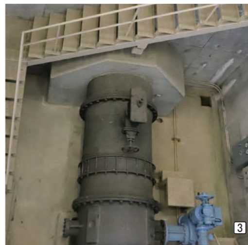
1_戸ノ口堰の猪取取水口は補修しながら維持管理しています 2_施設内の管理設備です 3と4_取水管には、1978年に製造された水道用バタフライ弁が使われています。重厚感があり歴史を感じます
