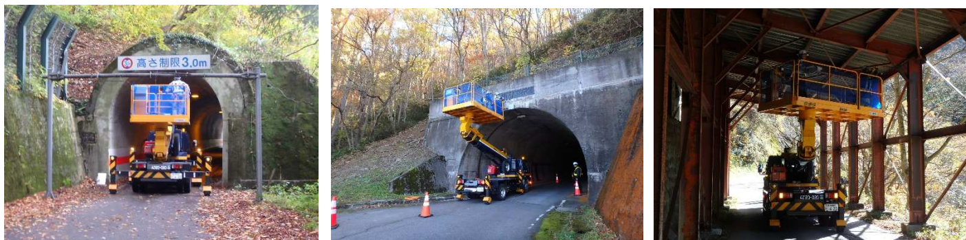
写真 3.2 トンネル定期点検の様子
