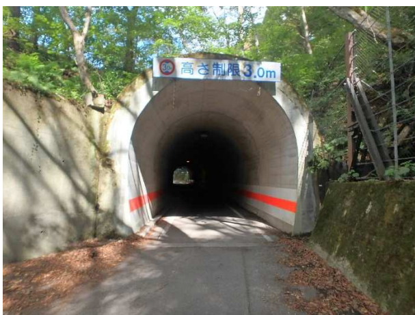
芦ノ牧トンネル
