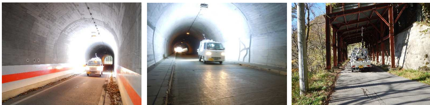
写真 3.3 走行型画像計測車による壁面撮影の様子
