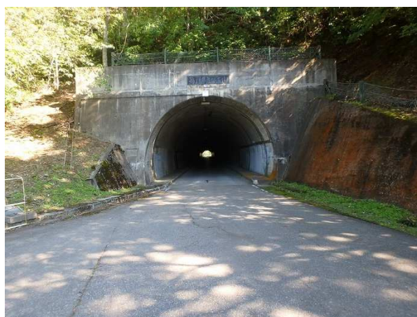
鞆ノ浦トンネル
