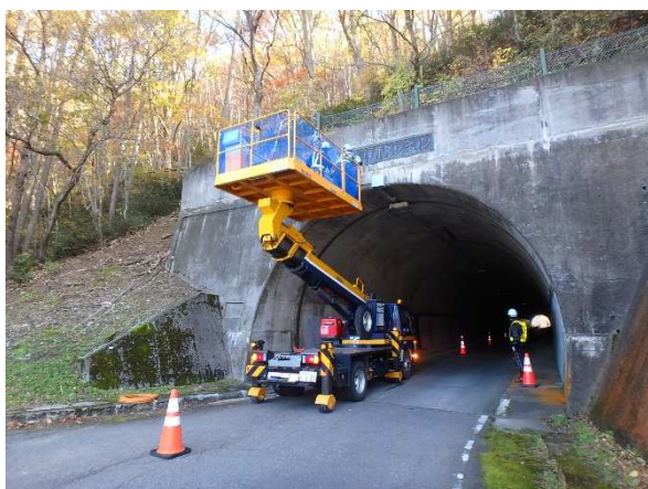
写真 4.2 高所作業車による点検
