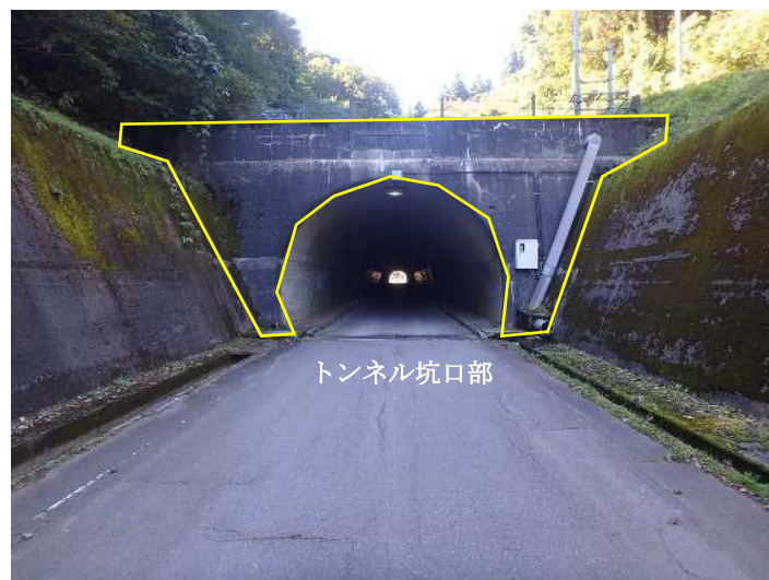
写真 4.1 トンネルの点検対象箇所
