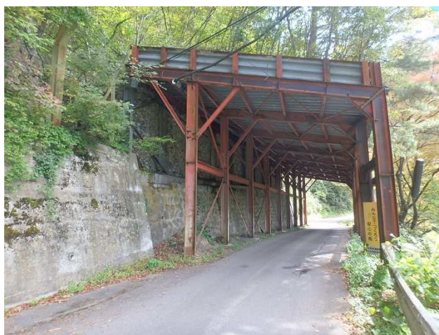
間川ロックシェッド
