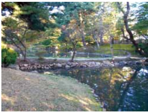
修復が完了した西池の護岸
