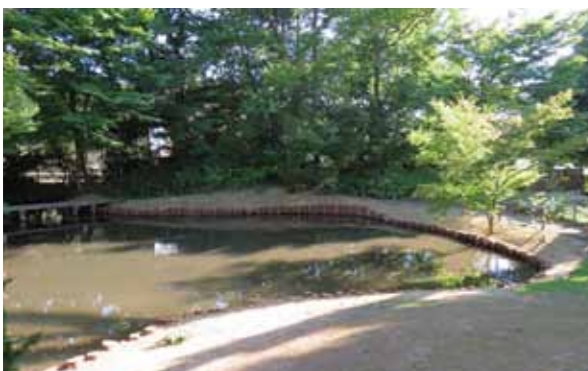
修復された西池の護岸
