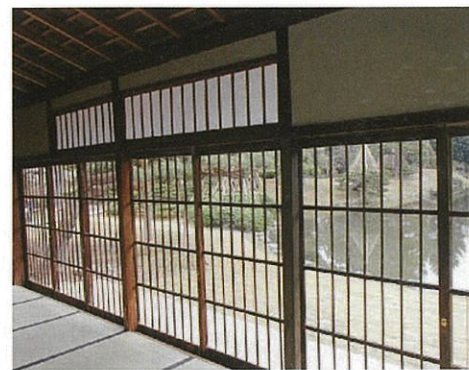
壁や欄間が修復された東側広縁
