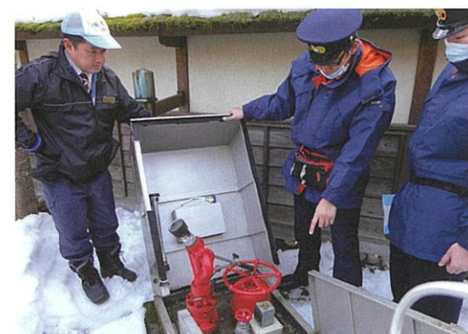
消火栓を点検の様子(茶室隣室にて)
