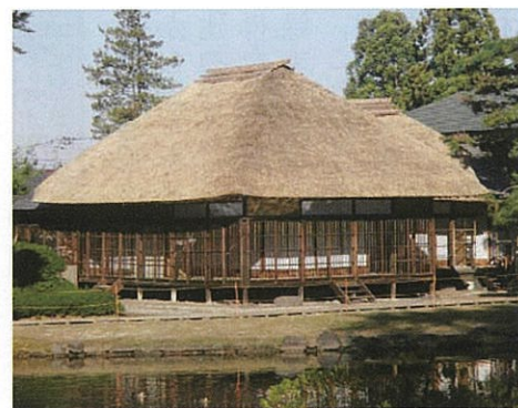
屋根が葺きかえられた御茶屋御殿
