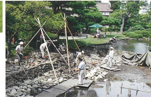
文化財庭園を江戸時代さながらの伝統技術で修復
