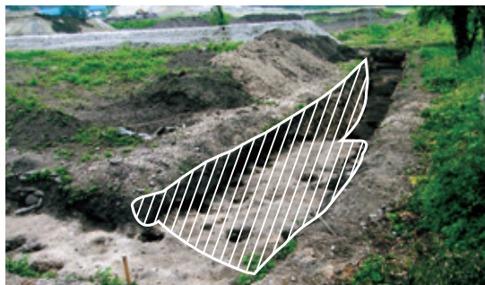
白い斜線の部分が土石流の後に堆積した土です。多量の土砂が積もっています。
