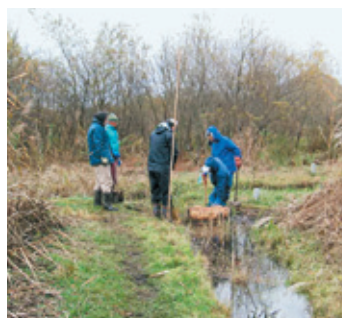
谷地からの水の流出を防ぐ場所に設置しています。
