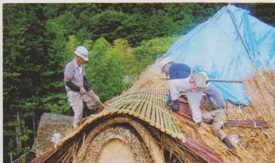
伝統の技術で行われる屋根葺き替え
