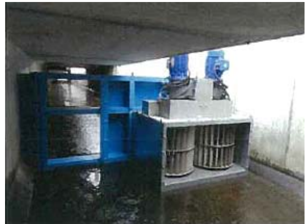
設置状況(例)写真
