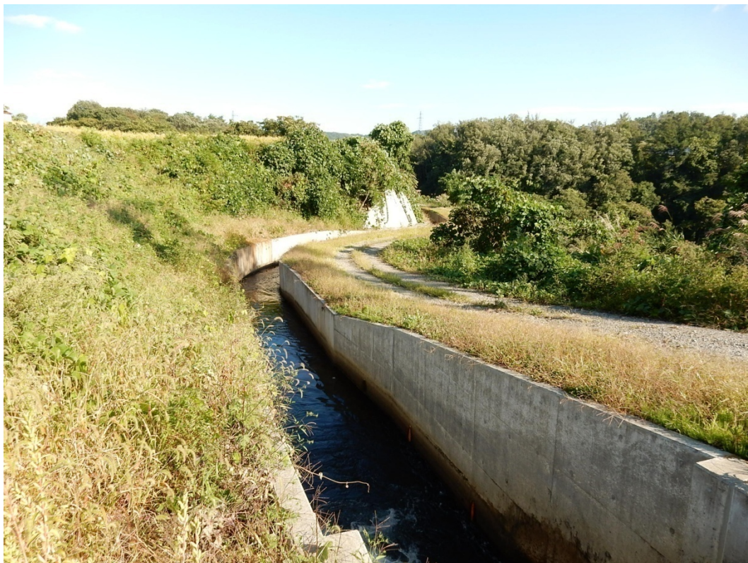
上堰幹線用水路 （河東町 八田 字赤坂乙）
