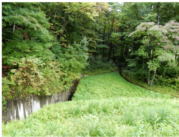
ため池の排水部
