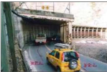
(三島町大字早戸字滝原地内)
