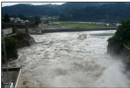
(只見線第6橋梁流出箇所 本名ダム直下)
