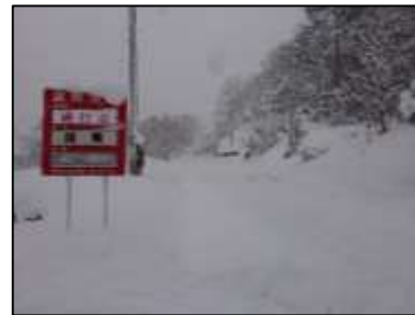
冬期間の通行不能（国道401号）
