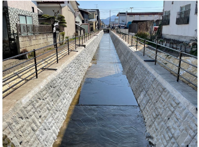
蟹川堀川水路整備工事 竣工後
