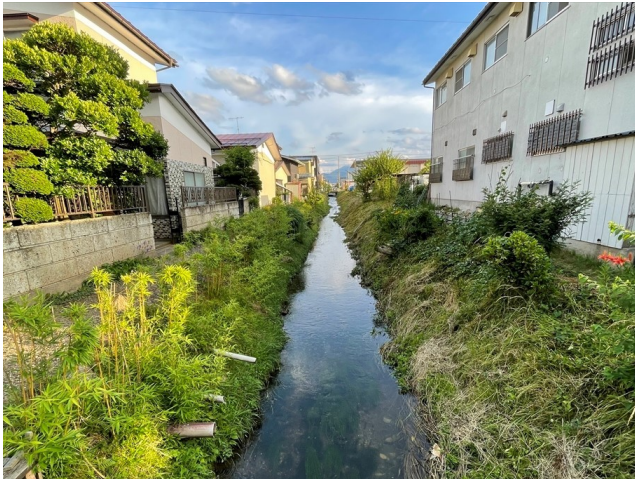
蟹川堀川水路整備工事 施工前
