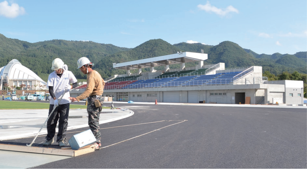
新陸上競技場は、3階建てのメインスタンドと全天候型のトラックを備え、エレベーターや多目的トイレもあるバリアフリー対応の施設です。現在、来年4月のオープンに向け整備が進んでいます
