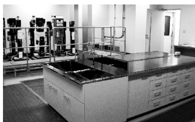
膜ろ過棟内の水質試験室
