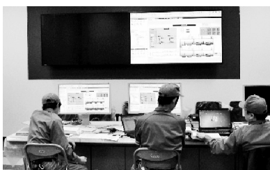
中央監視室内での試運転状況
