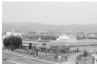
下水浄化工場では、今後汚泥消化ガスによる発電を計画しています
