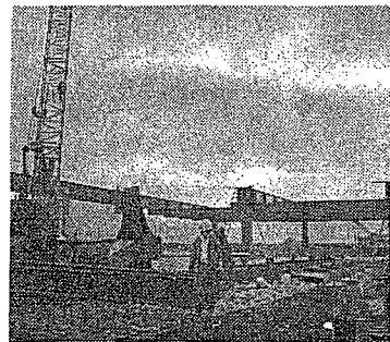
リズム時計の建設現場
