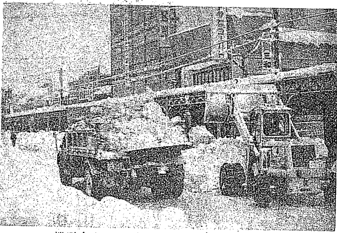
機動力をフルに動員して懸命の除雪作業
