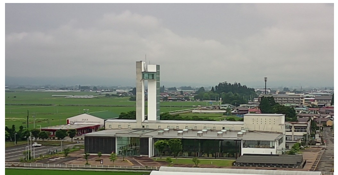
北会津支所庁舎
