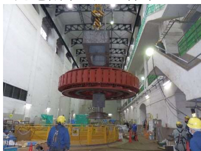
発電機吊り込み作業
