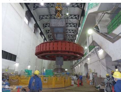
発電機吊り込み作業
