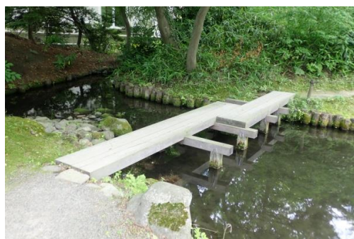
〔写真4-22〕 橋（木造橋（ハツ橋））
