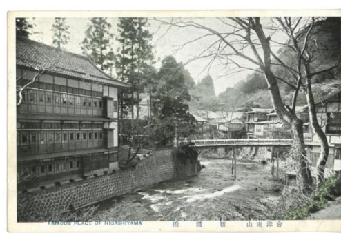
【写真3-23】「会津東山 新瀧橋」
