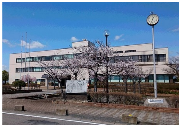
河東支所庁舎
