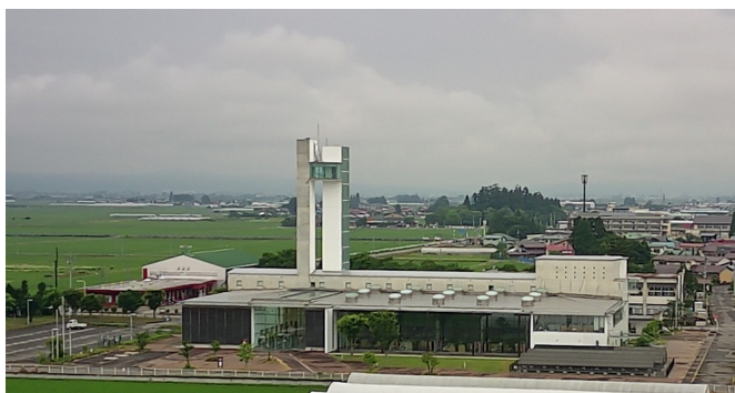
北会津支所庁舎
