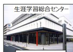
重要給水施設
