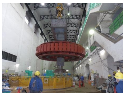
発電機吊り込み作業
