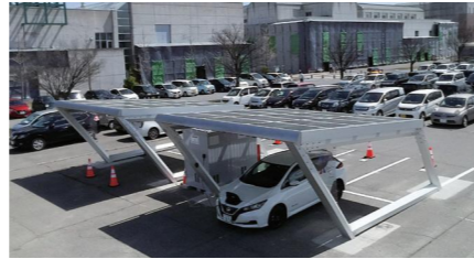
会津大学に設置されたカーポート
