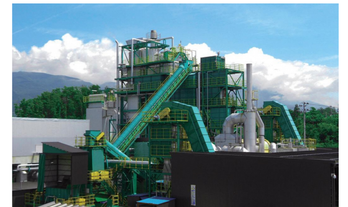
木質バイオマス発電所(グリーン発電会津)
