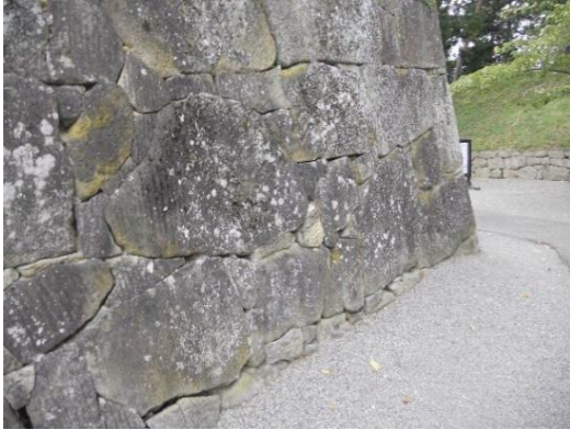
石垣の間詰め補修
