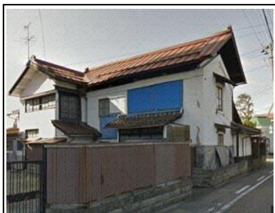
老朽化した歴史的建造物
