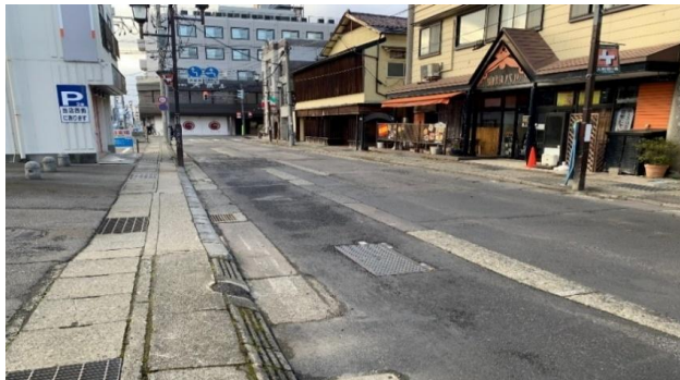
未整備区間状況
