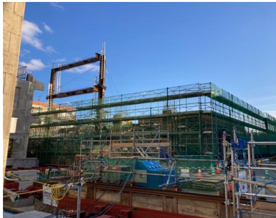
【新庁舎】躯体工事
