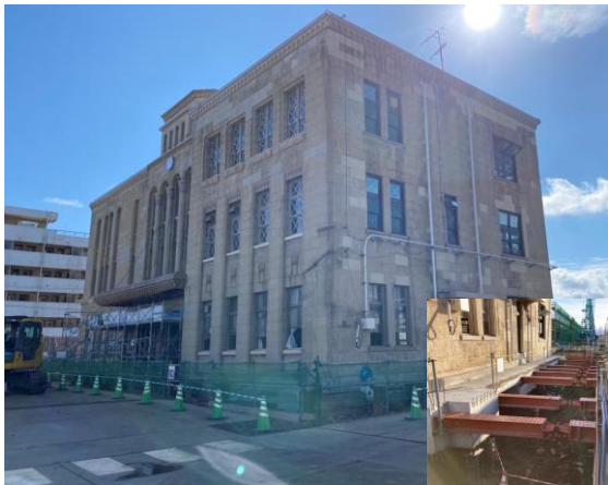
【本庁舎旧館棟】基礎工事
