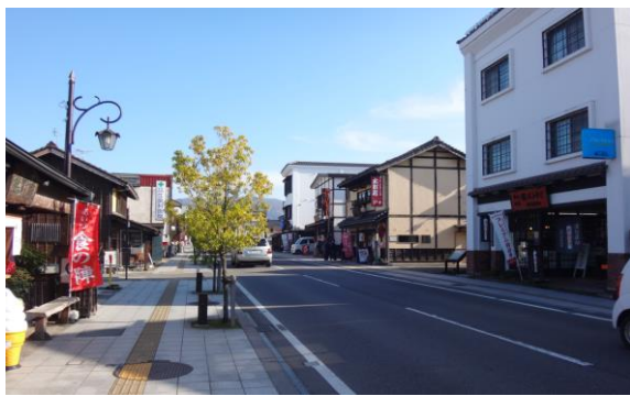
無電柱化済区間状況
