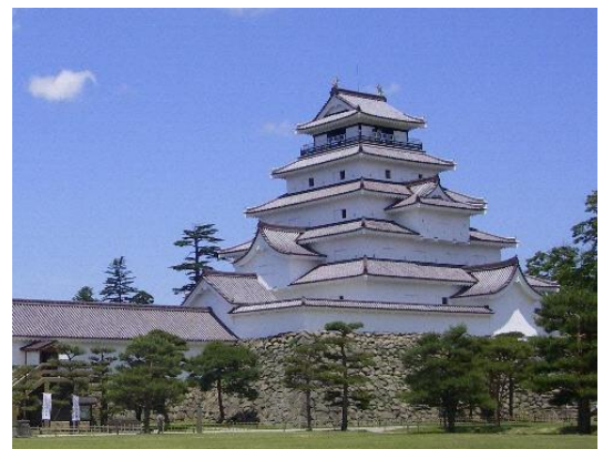
赤瓦に葺直された 鶴ヶ城（若松城）
