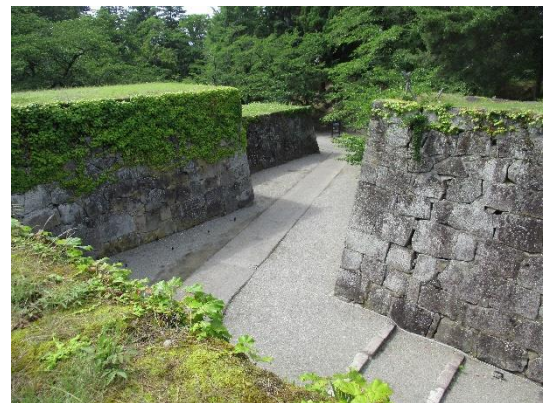
鶴ヶ城（若松城）石垣（廊下橋枳形）
