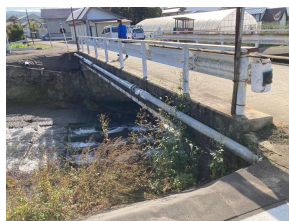
大工橋水管橋
