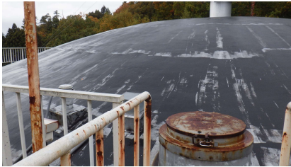
八幡配水池屋根防水更新工事
