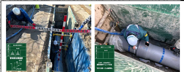
R6 東千石二丁目外 配管
